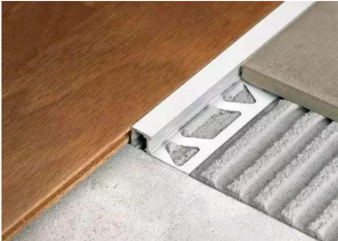
地砖、地板都会和铜条之间留有缝隙，地砖缝需要用填缝剂，地板缝需要打玻璃胶。
